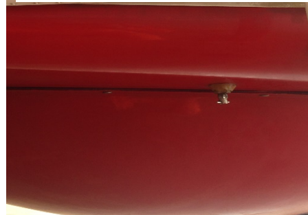
Dreno da linha de combustível
