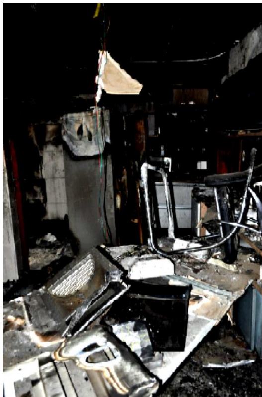
Figura 90 - Cenário de uma cozinha antes da reconstrução
