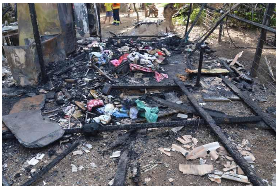
Figura 97 - Queima total de uma residência: origem indeterminada
