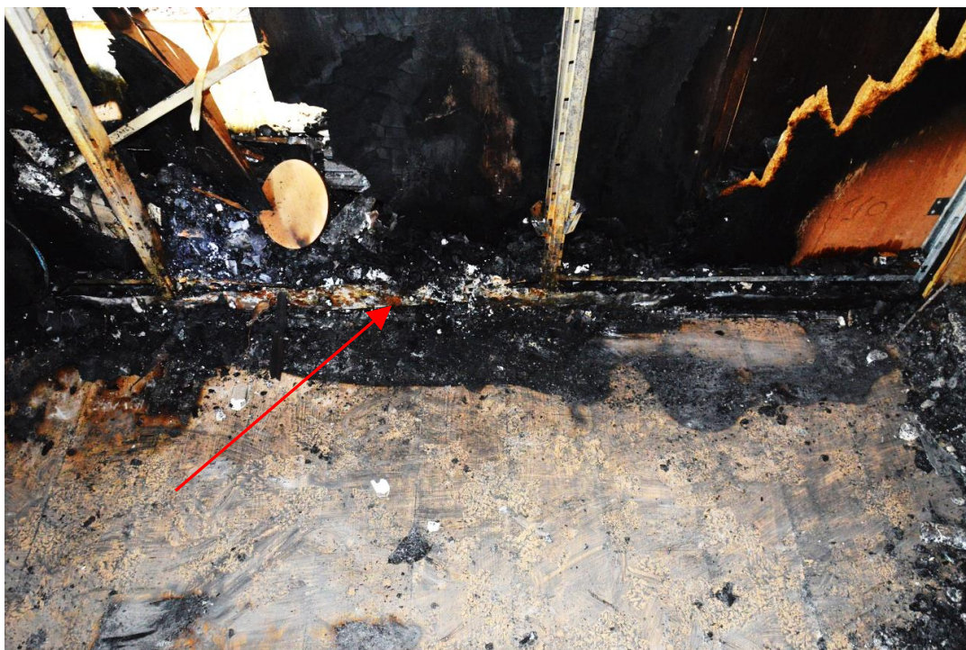
Figura 88 - Ponto de energia elétrica que foi encontrado após a escavação
