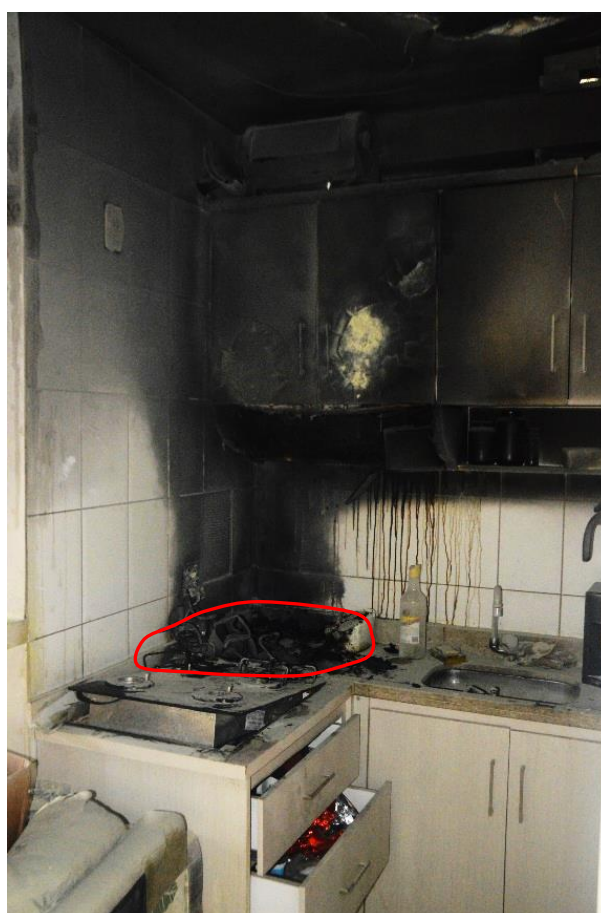
Figura 77 - A zona de origem foi a cozinha de um apartamento. O foco inicial situado sobre a bancada foi determinado a partir do padrão de queima na parede (cone truncado)
