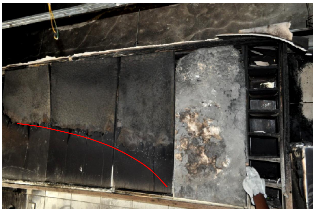
Figura 89 - A curva mostra que a queima ocorreu da direita para esquerda
