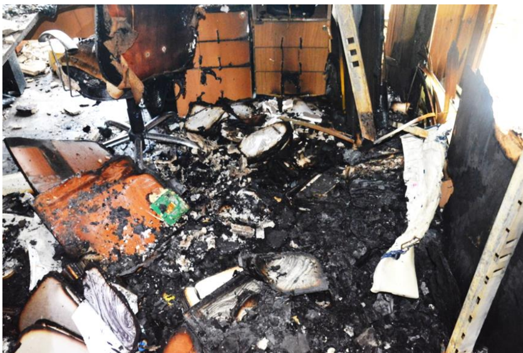
Figura 83 - Cenário do incêndio antes do início da etapa de escavação
