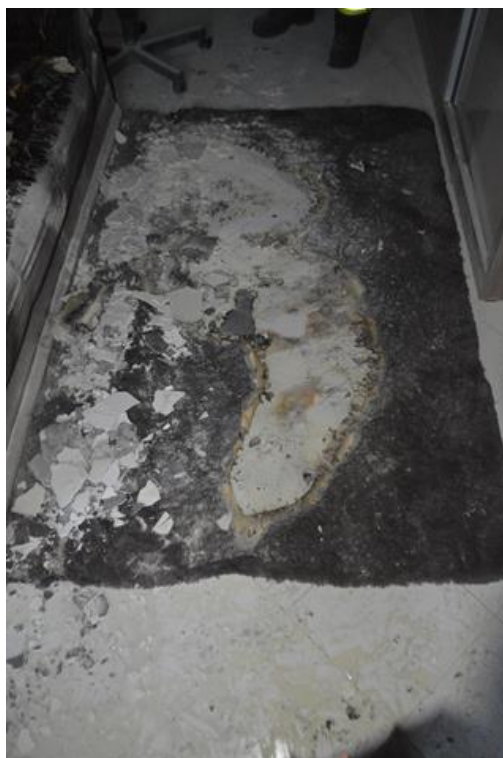
Figura 95 - Após reconstrução de um tapete, a análise do dado sugere a utilização de líquido inflamável no incêndio
