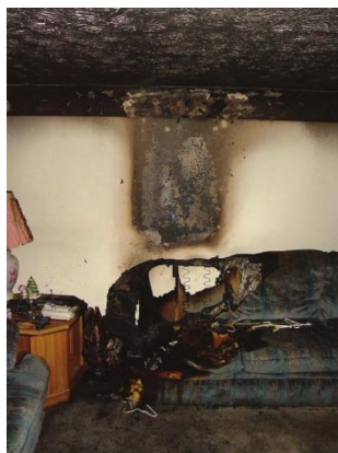
Figura 34 - Padrão coluna de queima em situação real
