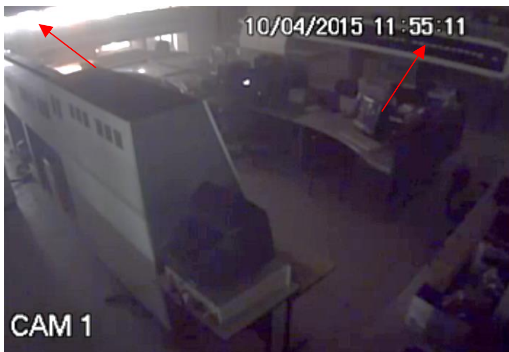
Figura 92 - A câmera de vídeo do circuito de segurança permitiu ao perito estabelecer a linha de tempo. As setas indicam o local e o horário do início do incêndio
