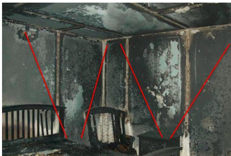
Figura 49 - Marcas de queima em incêndio debelado 40 segundos após a generalização do incêndio ( flashover )
