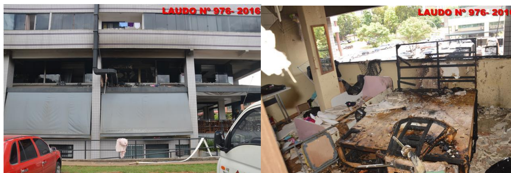
Figura 127 - Explosão em apartamento decorrente da impermeabilização do estofado
