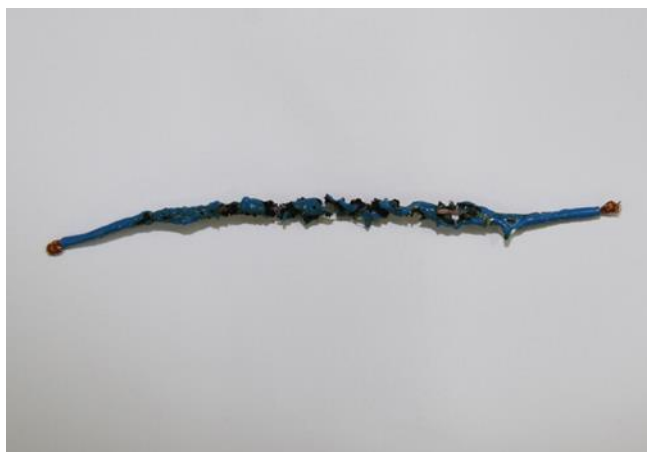
Figura 24 - Degradação do isolante do condutor elétrico
