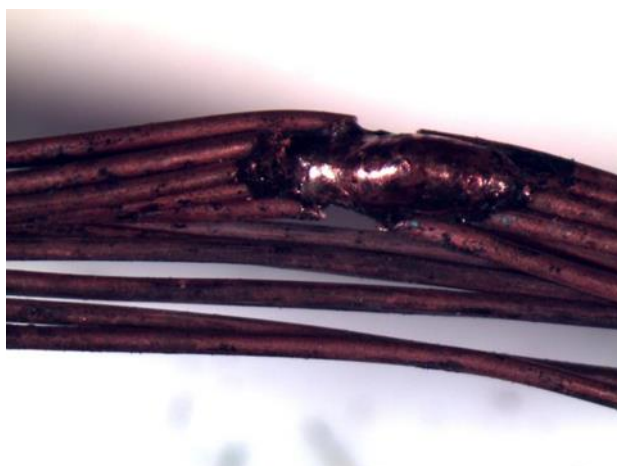
Figura 22 - Traço de fusão de sobrecarga sem ruptura
