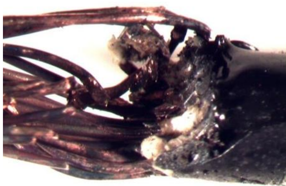
Figura 26 - Desconexão parcial em condutores flexíveis
