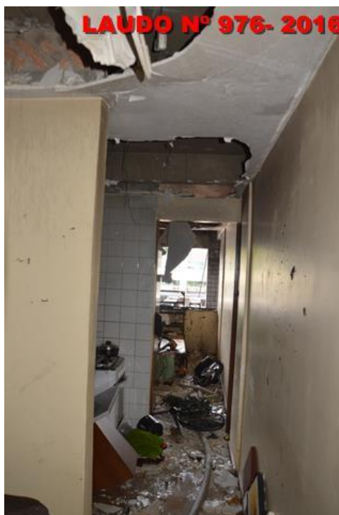
Figura 128 - Explosão em apartamento decorrente da aplicação de impermeabilizante no estofado
