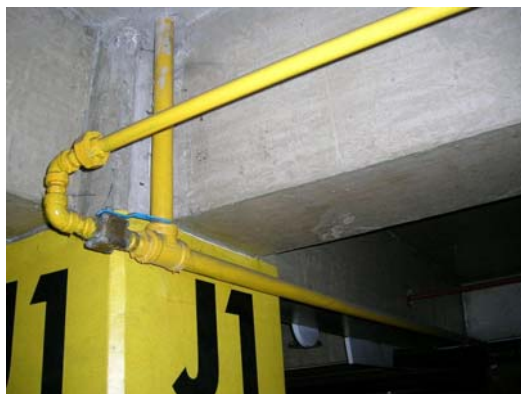
Figura 10.13 – tubulação aparente. Fonte: CBMDF.
