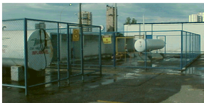
Figura 10.8 – afastamentos da central conforme tabela 10.3. Fonte: CBMDF.
