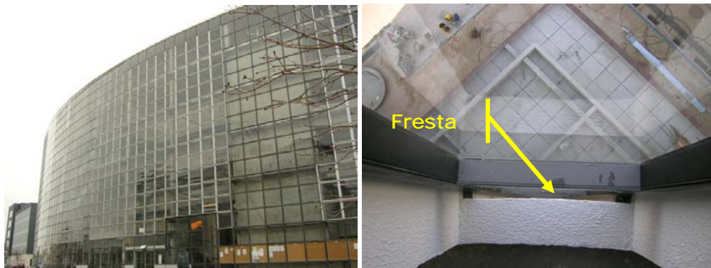
Figura 4.8 – prédio com fachada de vidro e fresta entre o vidro e a laje. Fonte: http://joaochezgeneve.blogspot.com ; CBMDF.
