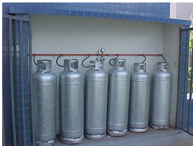
Figura 3.5 – Central de GLP. Fonte: CBMDF.
