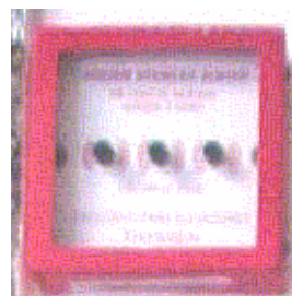
Figura 9.23 – chave comando bombeiro Fonte: CBMDF.
