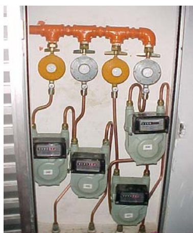
Figura 10.16 – cabine de medidores Fonte: CBMDF.
