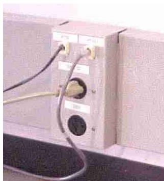
Figura 9.11 – Eletroduto tipo perfilado Fonte: CBMDF.
