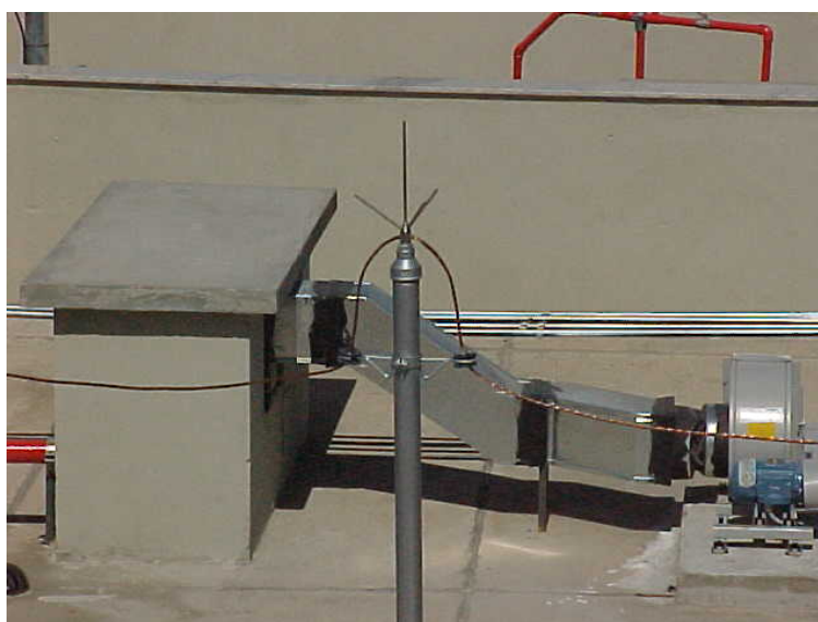
Figura 3.6 – Captor tipo Franklin do SPDA. Fonte: CBMDF.
