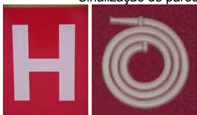
Figura 6.7 – Sinalização de hidrante e mangueira
