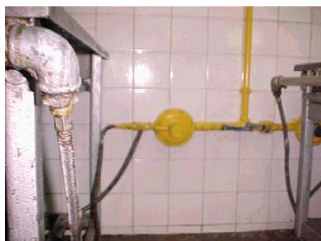
Figura 10.12 – mangueira revestida em malha de aço. Fonte: CBMDF.
