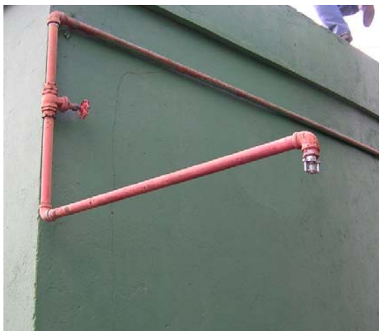
Figura 3.10 – Tubulação e bico de sprinkler. Fonte: CBMDF.
