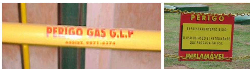
Figura 10.17 – sinalização da canalização e da central.
