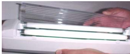
Figura 7.9 – Lâmpada Florescente em Bloco autônomo Fonte: CBMDF.
