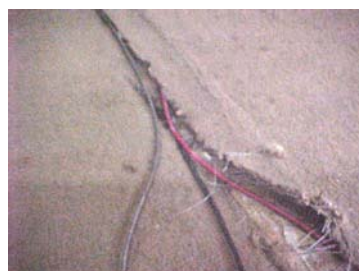
Figura 9.17 – Fiação desprotegida, solta, em local inapropriado e danificado
