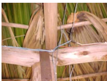
Figura 9.16 – Fiação desprotegida e com falhas em emendas
