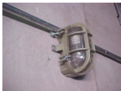
Figura 9.21 – Instalação adequada em locais de risco
