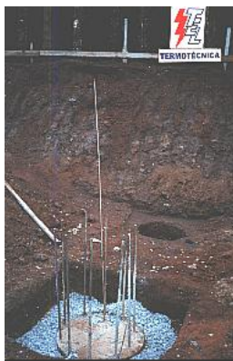
Figura 8.13 – Eletrodo de aterramento de fundação Fonte: www.tel.com.br
