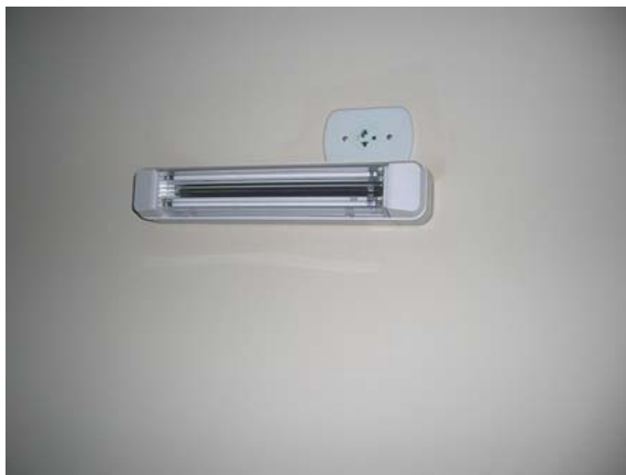
Figura 3.2 – Bloco autônomo do sistema de iluminação de emergência.
