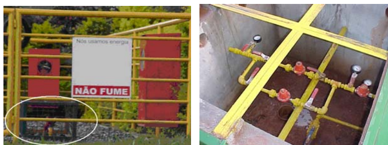
Figura 10.6 – caixas de inspeção de superfície e enterrada. Fonte: CBMDF.
