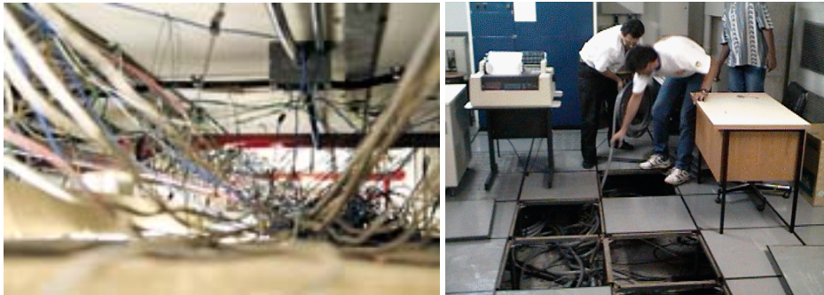
Figura 4.7 – Fiação passando entre a laje e o forro; piso falso para cabeamento. Fonte: hydra.lcc.ufmg.br/lcc/galeria.html .
