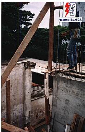
Figura 8.14 – Armações de aço interligadas Fonte: www.tel.com.br
