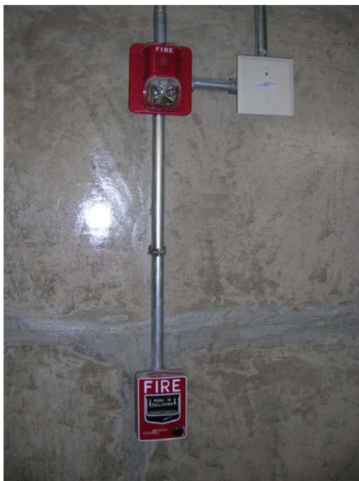
Figura 3.4 – Acionador manual e avisador áudio-visual. Fonte: CBMDF.
