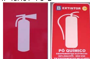
Figura 6.8 – Sinalização de extintor
