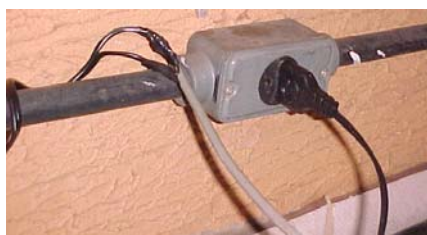
Figura 9.12 – Eletroduto em PVC
