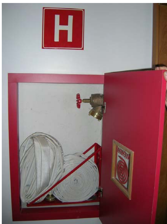
Figura 3.9 – Abrigo do hidrante de parede. Fonte: CBMDF.
