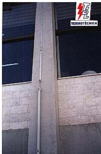
Figura 8.12 – Condutor de descida. Fonte: www.tel.com.br
