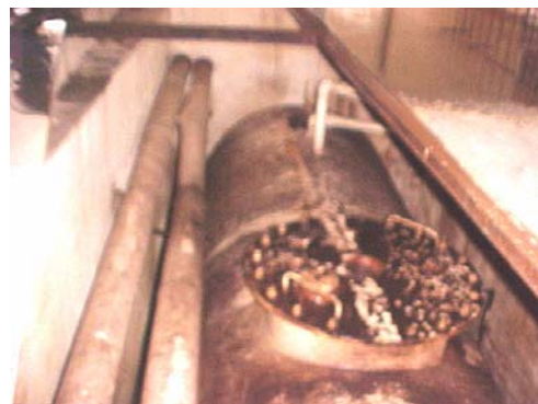
Figura 7.6 – tanque de diesel para alimentação do gerador
