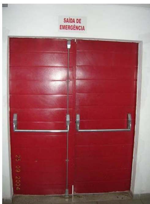
Figura 5.2 – Porta corta fogo dotada de ferragem antipânico. Fonte: CBMDF.
