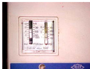
Figura 9.21 – pressostato com regulagem aparente
