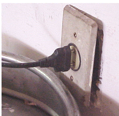
Figura 9.18 – Tomada solta e extensão danificada
