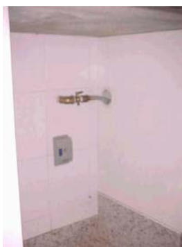
Figura 10.15 – registro de corte e detector de vazamento no ponto de consumo. Fonte: CBMDF.
