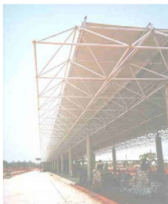
Figura 8.20 – Cobertura metálica funcionando como captor natural.
