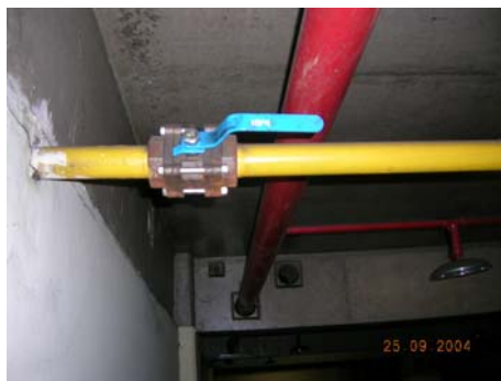
Figura 10.9 – válvula de bloqueio (registro de corte) Fonte: CBMDF.
