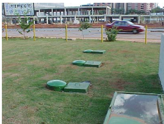
Figura 10.7 – afastamento entre tanques Fonte: CBMDF.
