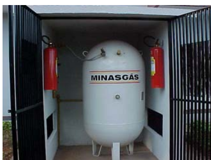
Figura 10.18 – extintores da central de GLP Fonte: CBMDF.
