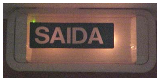
Figura 7.19 – Sinalização iluminada instalada acima da porta com texto apostro
