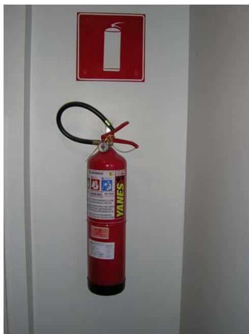
Figura 3.8 – Extintor de incêndio. Fonte: CBMDF.
