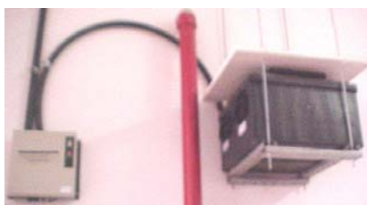
Figura 7.4 – Bateria e quadro de iluminação de emergência Fonte: CBMDF.
