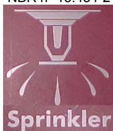
Figura 6.12 – Sinalização do alçapão ou porta de acesso ao registro de corte dos SPKs
