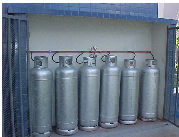
Figura 10.4 – abrigo da central de GLP para recipientes transportáveis. Fonte: CBMDF.
