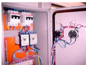
Figura 9.22 – quadro de bombas
