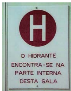
Figura 6.6 – Sinalização adicional. Fonte: CBMDF.
