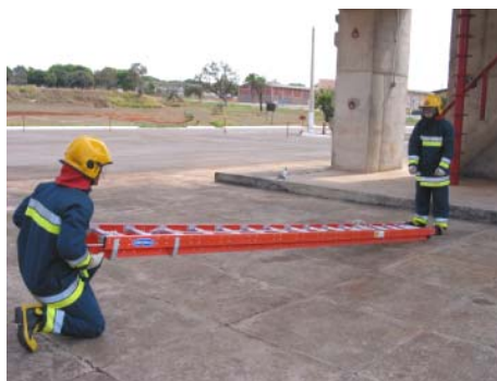
Figura 119 - Posicionamento da escada
