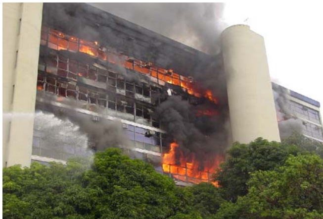
Figura 153 - Incêndio no prédio do INSS, em Brasília-DF — 2005
