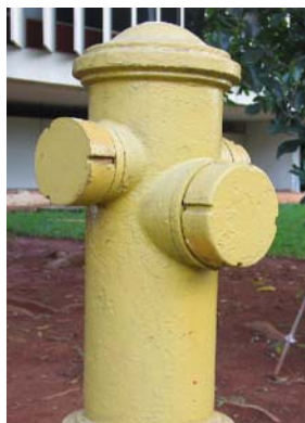
Figura 46 - Hidrante urbano ou de coluna
