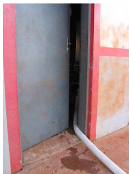
Figura 195 - Manter a porta semi-fechada, evitando a propagação do fogo em direção à entrada dos bombeiros.
