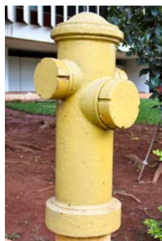
Figura 140 - Hidrante urbano (ou de coluna)
