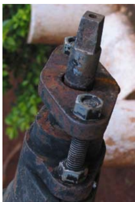
Figura 53 – Exemplo de registro da válvula do hidrante
