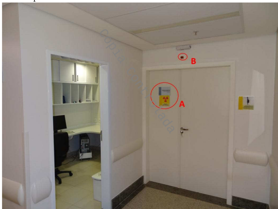
Figura 8 – Sistemas de segurança da sala de simulação virtual. A – Símbolo internacional de radiação ionizante na entrada da sala. B - Iluminação indicando feixe ligado.
