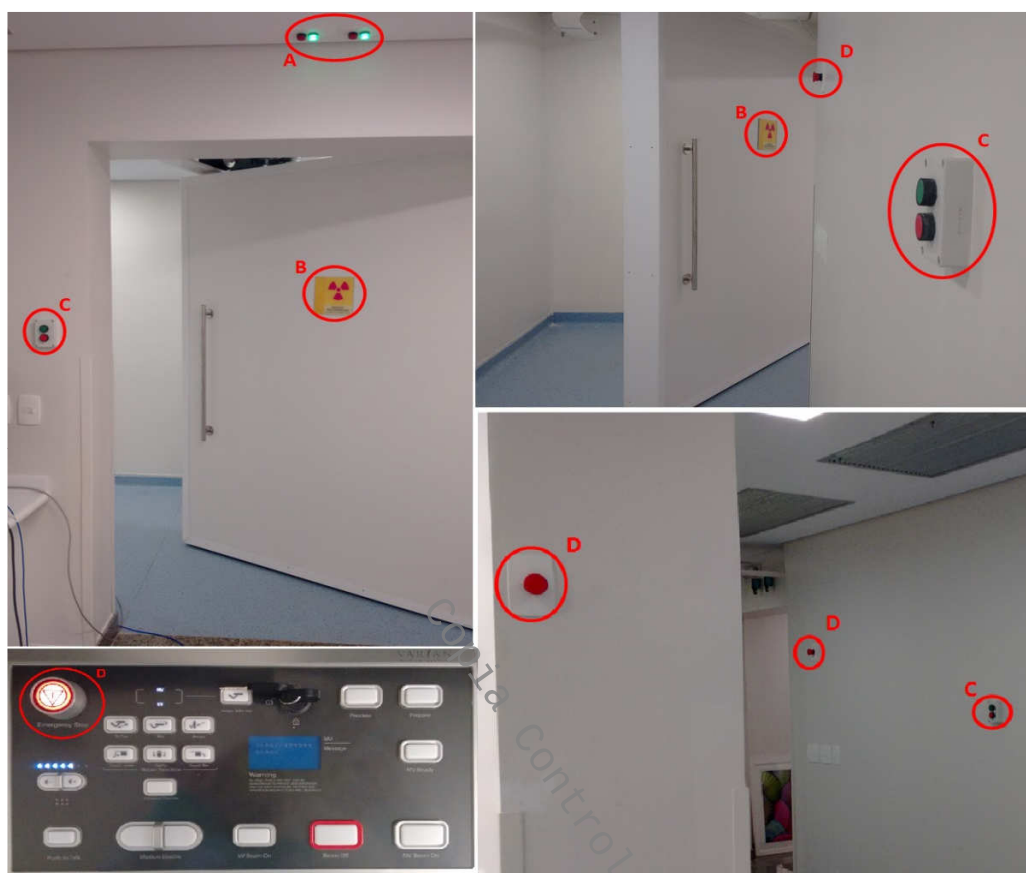
Figura 4 – Sistemas de segurança da sala de tratamento: A – indicação luminosa de feixe ligado / desligado; B – símbolo internacional de radiação na porta da sala; C – Botão de fechamento / abertura da porta nas partes interna e externa da sala de tratamento; D - Botões de emergência no console, nas partes externa e interna da sala.
