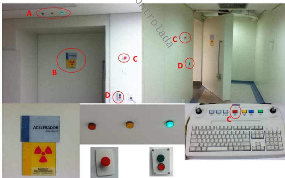
Figura 6 – Sistemas de segurança da sala de tratamento: A – indicação luminosa de feixe ligado / desligado; B – símbolo internacional de radiação na porta da sala; C – Botões de emergência no console, nas partes externa e interna da sala; D - Botão de fechamento / abertura da porta nas partes interna e externa da sala de tratamento.
