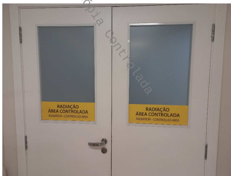
Figura 2. Portas que controlam o acesso às áreas da instalação.
