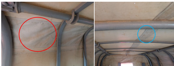
Figura 7 e 8: Reforço interno lateral e central respectivamente.
