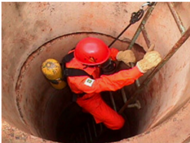
Figura 256: uso de escada para descida em poço.
