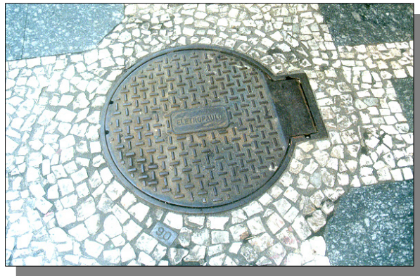
Figura 302: tampa de uma estação elétrica subterrânea.
