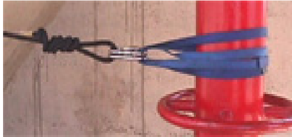
Figura 57: lingas com fitas usadas para ancoragem.
