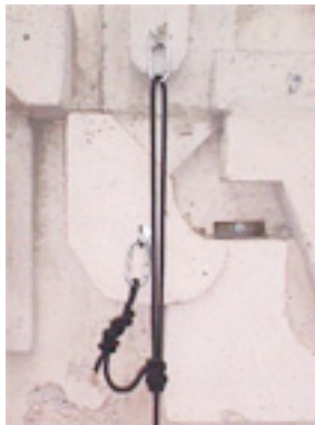
Figuras 472: ancoragem em dois pontos evita impactos em caso de falha.
