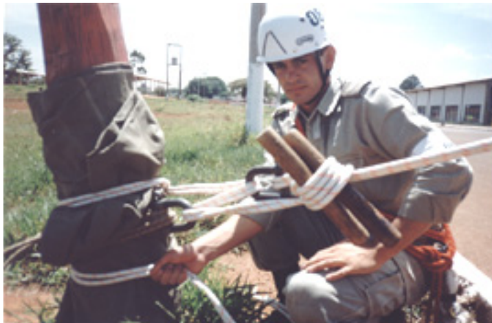
Figura 48: exemplo de ancoragem
