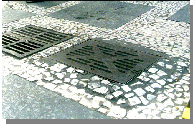
Figura 304: Grelha de ventilação
