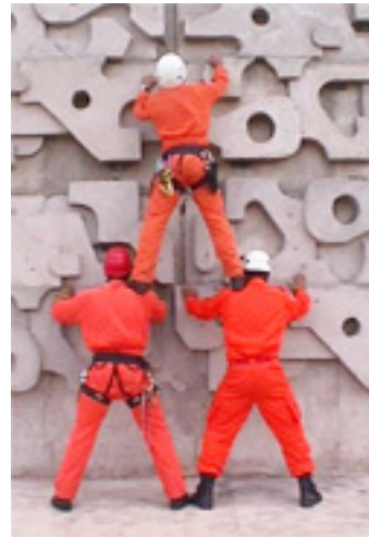
Figuras 121, 122, 123, 124, 125 e 126, respectivamente: ilustração da técnica escada humana.
