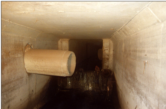
Figura 300: galeria de águas pluviais.
