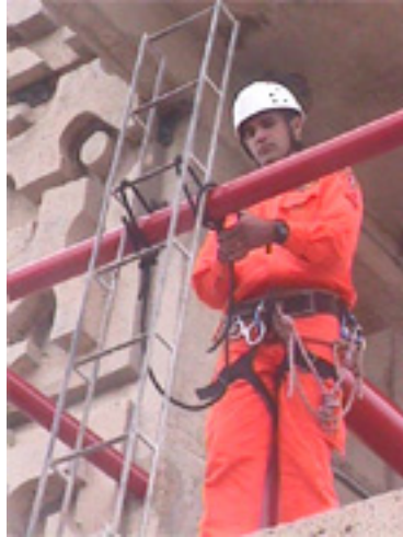
Figura 263: fixação da escada.
