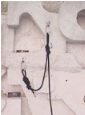
Figuras 472: ancoragem em dois pontos evita impactos em caso de falha.
