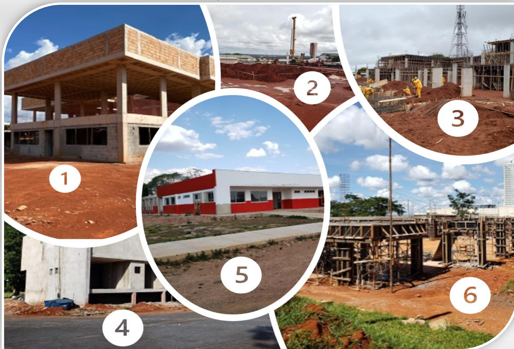
Figura 63 – Panorama das obras do CBMDF
