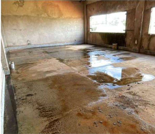
Figura 41: Granitina sem polimento – Térreo Bloco C
