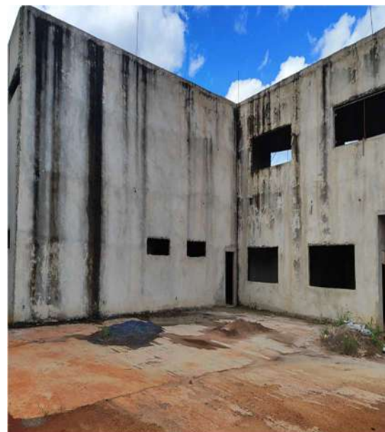
Figura 9: Área sem contrapiso - Térreo Bloco A
