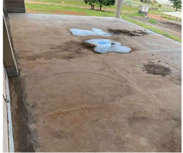
Figura 42: Granitina sem polimento – Térreo Bloco C
