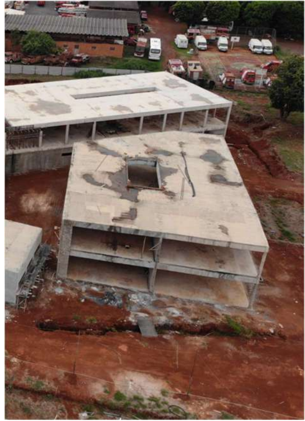
Figura 36: Alvenaria cobertura – Bloco C
