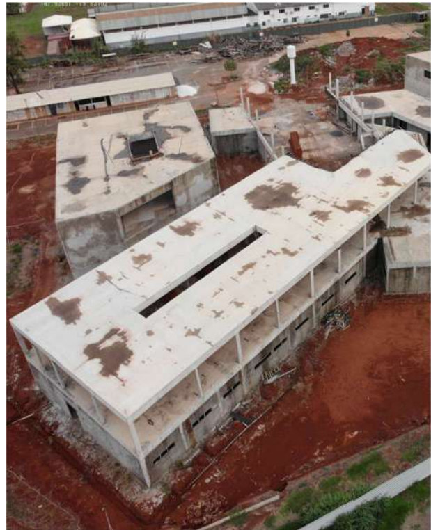
Figura 26: Alvenaria cobertura – Bloco B
