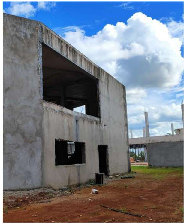
Figura 22: Alvenaria passarela/corredor 1º Pav. – Bloco B
