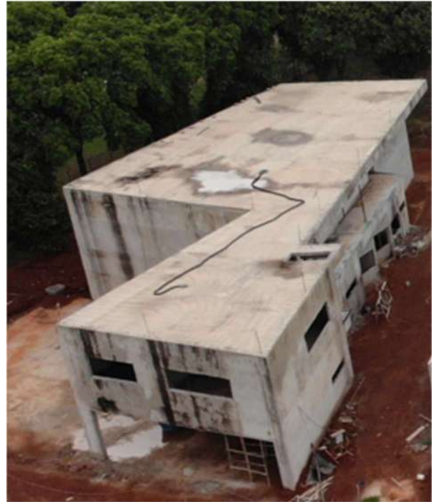
Figura 7: Área da cobertura
