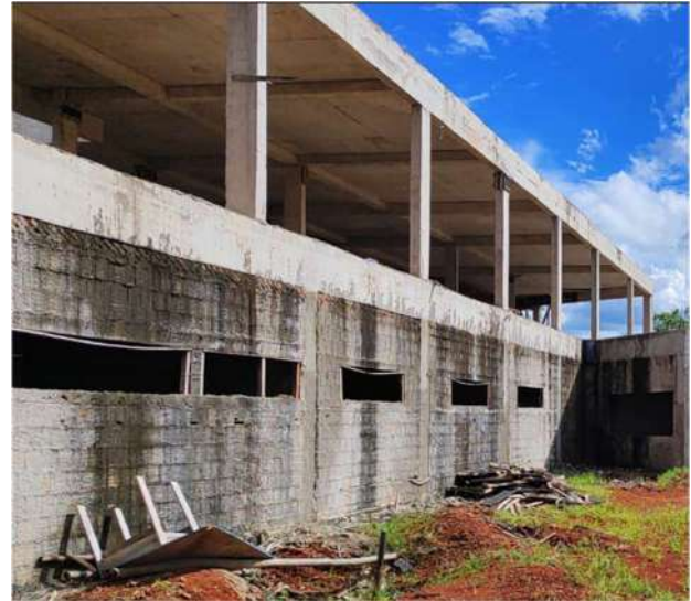
Figura 28: Reboco e chapisco fachada – Bloco B
