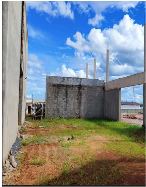
Figura 20: Alvenaria passarela/corredor térreo – Bloco B
