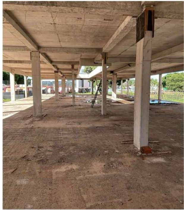
Figura 24: Alvenaria 1º Pav. – Bloco B
